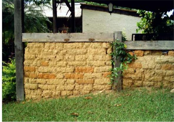
Figura 317 – Detalhe do muro de adobe (Acervo PROAU/FAU/UnB).
