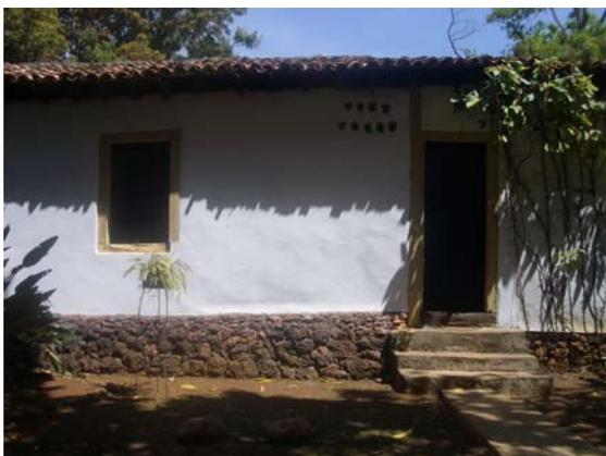
Figura 314 – Detalhe da fundação de pedra (Acervo PROAU/FAU/UnB).
