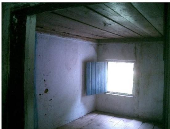
Figura 177 – Detalhe da janela de madeira de uma folha (Foto: Vera Braun Galvão, 2005).
