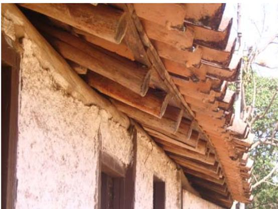
Fachada 252 – Detalhe da estrutura do telhado em madeira com telhas de barro (Acervo PROAU/FAU/UnB).
