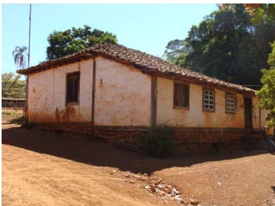
**Figura 192 – Fachada lateral e fundos, vendo-se detalhe do cunhal e baldrames de madeira (Acervo PROAU/FAU/UnB).**
