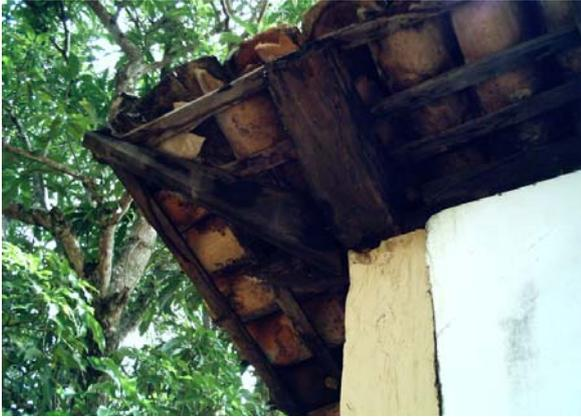
Figura 316 – Detalhe da estrutura do telhado em madeira (Acervo PROAU/FAU/UnB).
