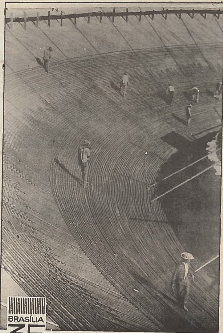
Operários armando estrutura das galerias da Câmara
