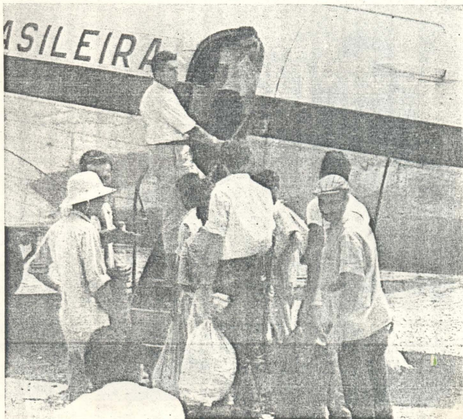
4. Bernardo Sayão, quando ainda vivo, incentivava os trabalhadores para acompanhá-lo na difícil tarefa de abrir a estrada Brasília-Belém.
