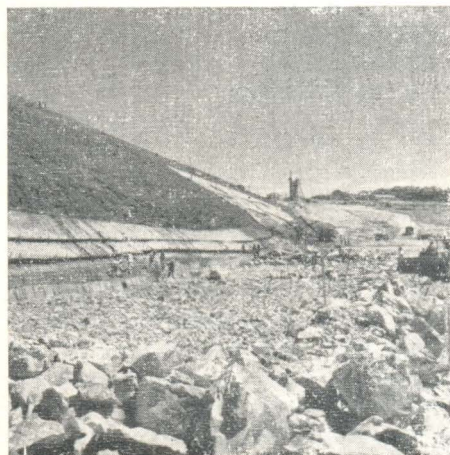
20 — Bloco de apartamentos do Iapi. 21 — Barragem do Paranoá. (Fotos de Franceschi).
