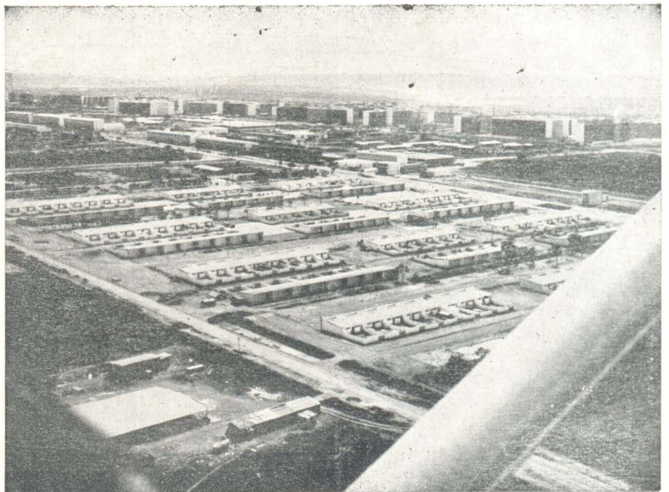
1 - Vista geral de Brasília. 2 - Aspecto das casas populares (Fotos A.N.).
