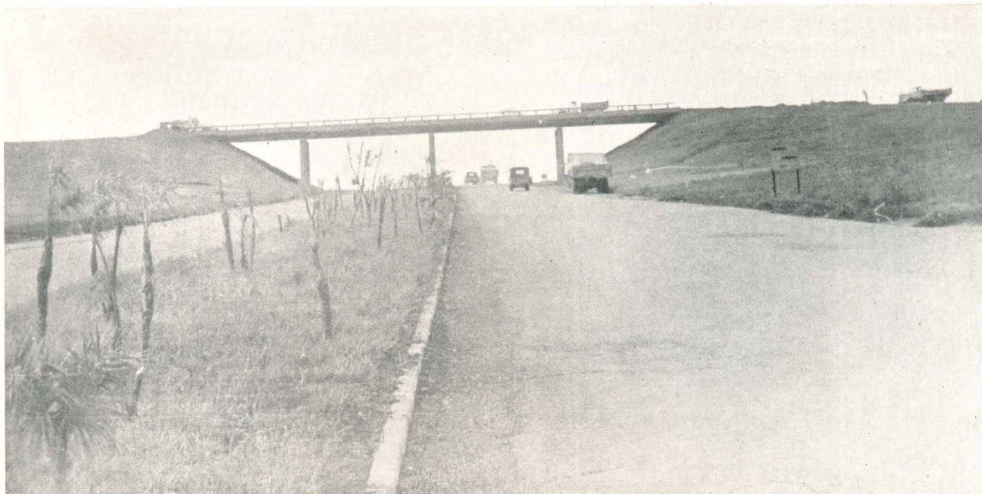
Viaduto em um dos trevos.
