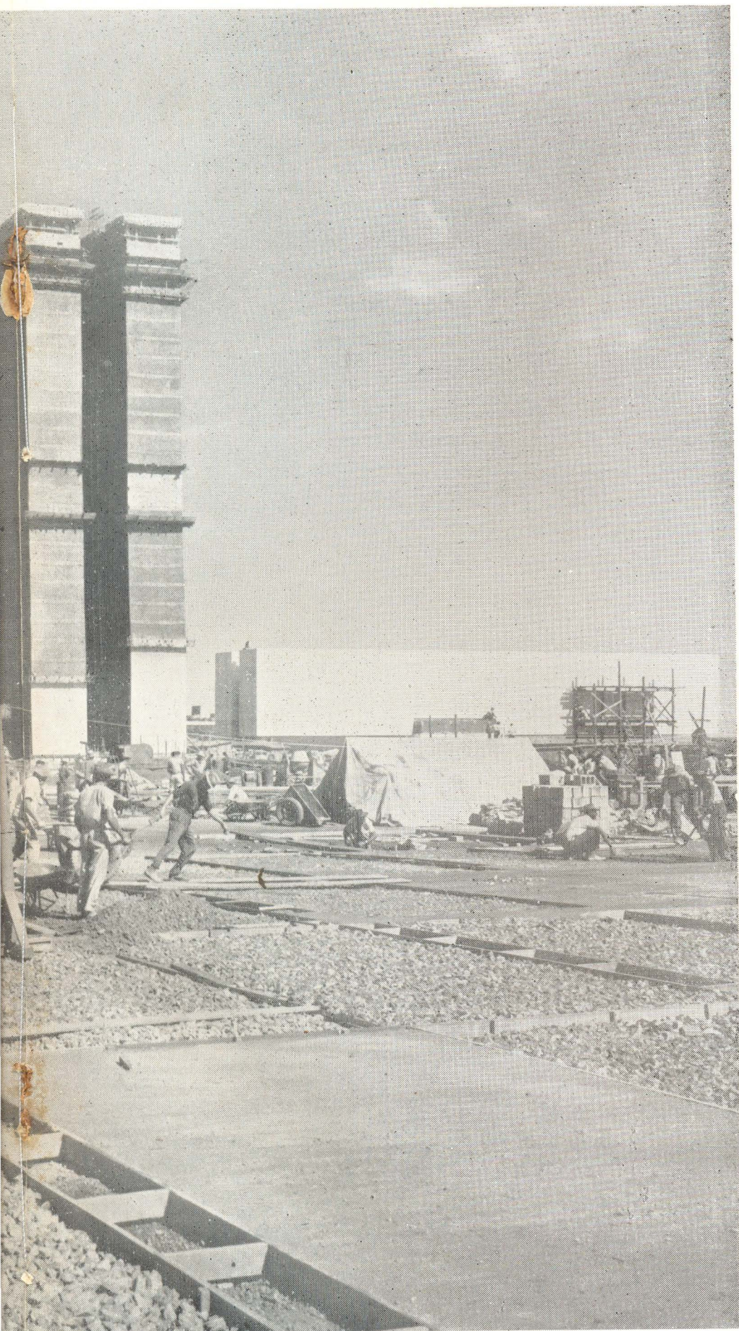
Concretagem do espelho d'água em frente ao Congresso Nacional.
