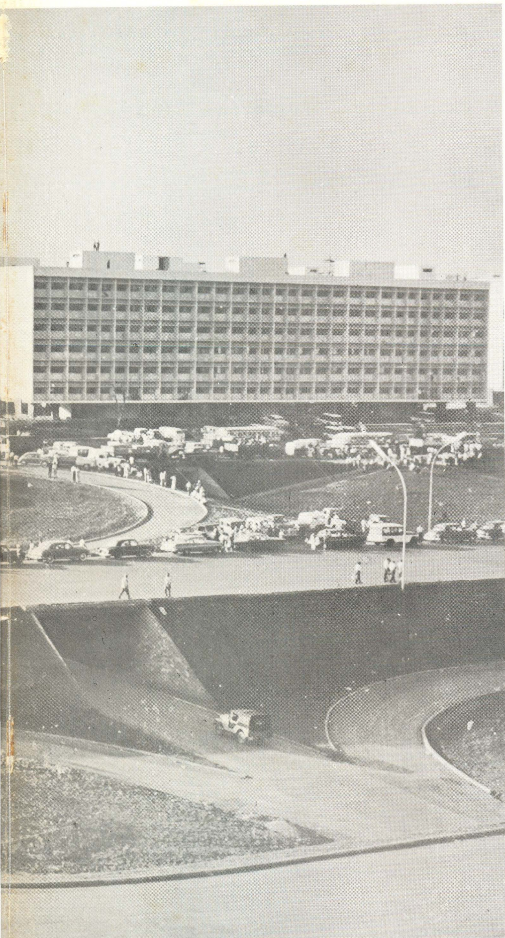
Vista aérea parcial, destacando-se um dos trevos, com passagem de nível, em franco funcionamento.
