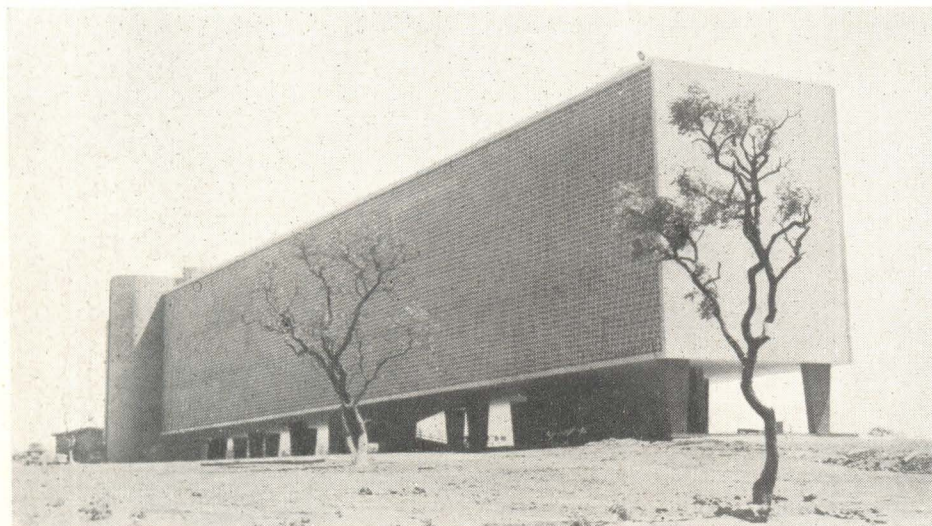
A fachada posterior do colégio D. Bosco.
