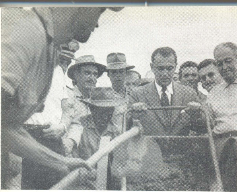
● S. Exa. faz questão de despejar, êle mesmo, uma carrada de concreto...
