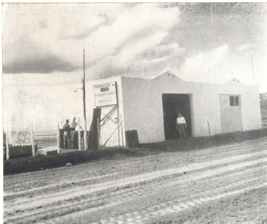
13. Escritórios da Temag, primeira firma a construir no Plano Piloto de Brasília: Pôsto Esso e Central Telefônica Sul
