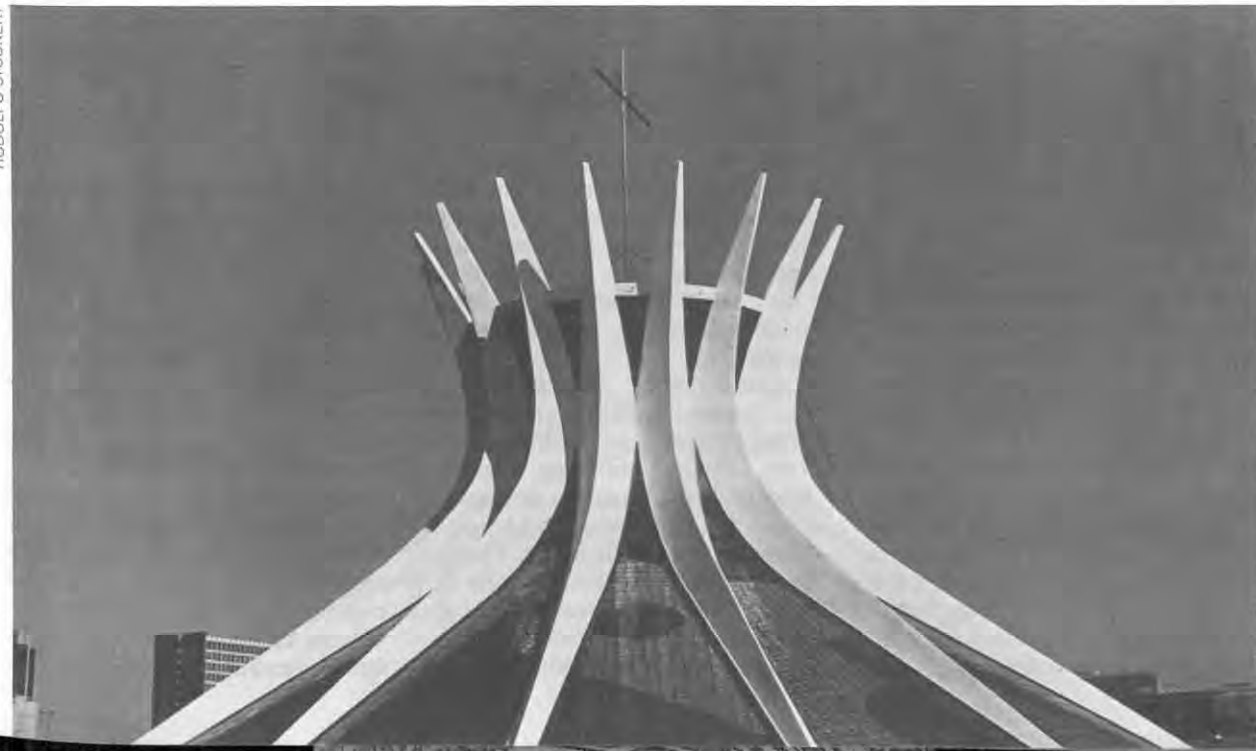
A Catedral já está toda vestida de branco, como devem ser as catedrais, segundo Niemeyer, e parte dos vitrais novos já foi colocada
