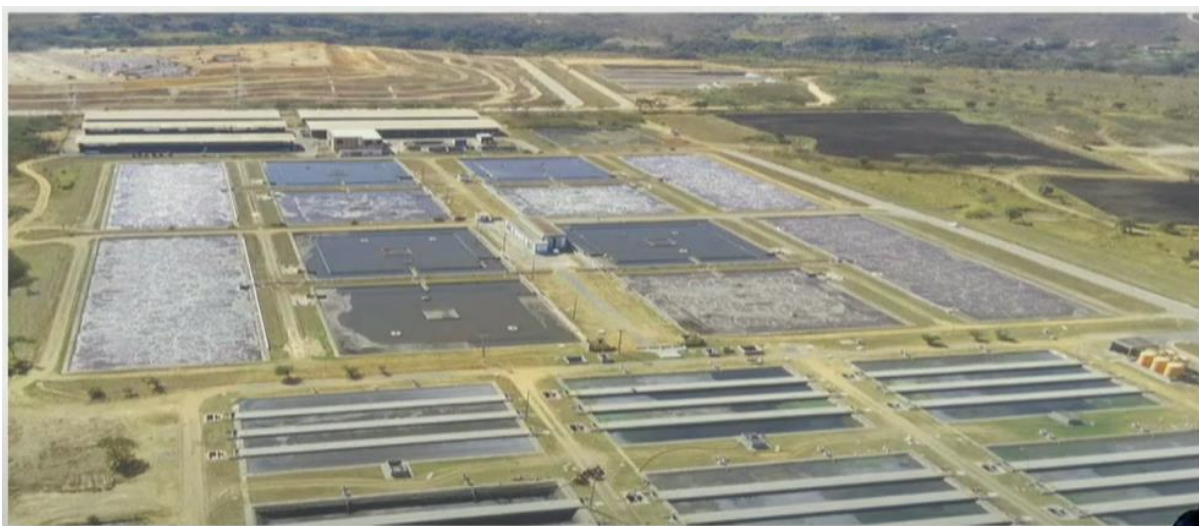
Imagem 39. Revitalização de todo o sistema de aeração dos reatores biológicos da ETE Melchior.
